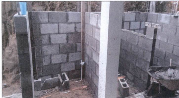
Foto 3: fundición de columnas de hierro y concreto
