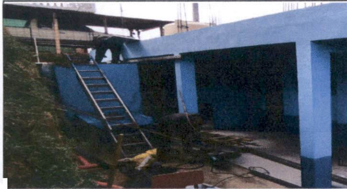
Foto1: Colocacion de lámina zinc y puertas
