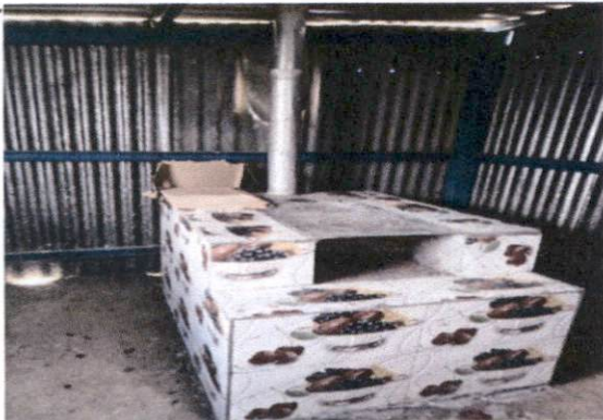
Foto 3: Sustitución de estufa rural (completa) incluye chimenea y plancha de metal.
