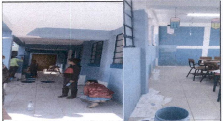
Foto 2: Pintura en muros exteriores e interiores
