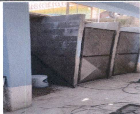
Foto 4: Puertas de metal en baños y sustitución de lámina, por lámina troquelada calibre 26
