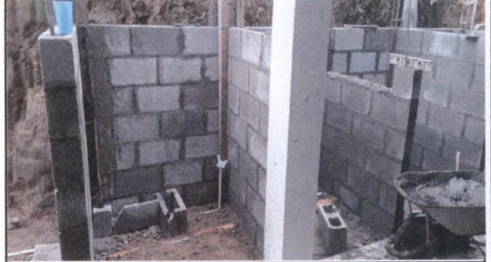
Foto 2: Levantado de paredes de block
